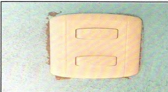
Sustitución de tomacorriente
