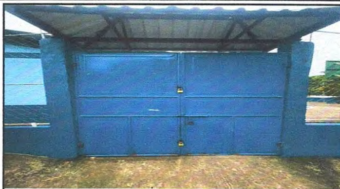
Sustitución de Portón
