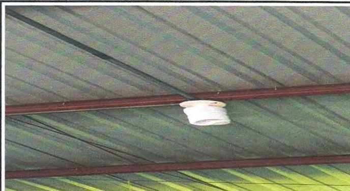
Reparación de Sistema Eléctrico
