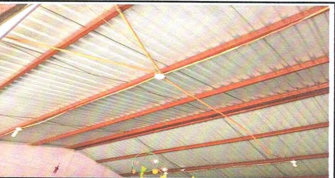
Reparación de Sistema Eléctrico
