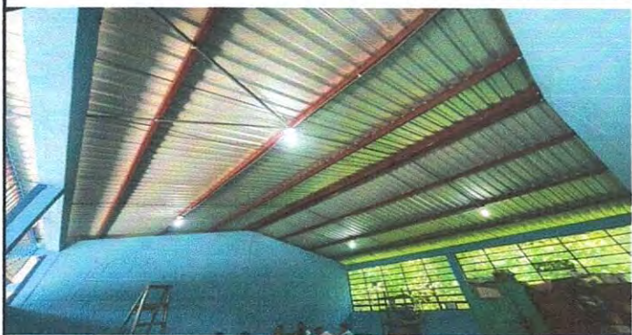
Reparación de sistema eléctrico
