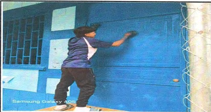
Sustitución de puertas
